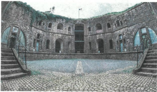
Le fort Dorsner dispose d'un haut massif central de plus de 15 mètres qui abrite en son sein une cour donnant jour à des locaux à deux niveaux côté nord. Il était en capacité de tenir un siège de cinq mois. Photo Michaël Desprez
